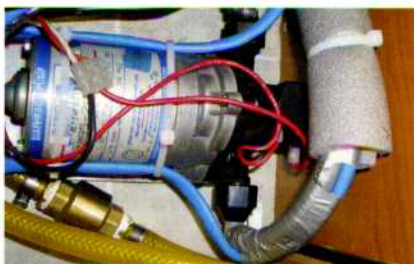
Przewód grzejny na pompce wodnej i rurze z wodą czystą.
